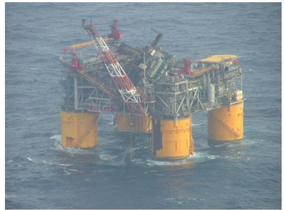
图7. "Katrina"飓风对308航次钻井区的海上石油钻井平台的破坏。
